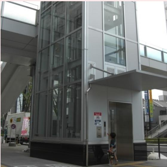
ちなみに上の写真は私の地元の駅に設置されているエレベーターで、ドアが両方向にあるため車椅子が中で方向転換をしなくても出られるようになっています。車椅子が方向転換するには 1.5m 四方ほどのスペースが必要になるので、エレベーターのサイズも大きくなってしまいます。これなら小スペースで設置できますし、面白いアイデアだと思いました。
